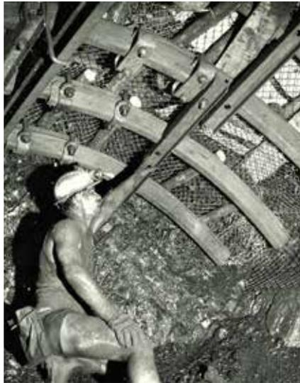
*Mise en place du soutènement dans une galerie au charbon avec garnissage en bois et grillage non plastifié*
