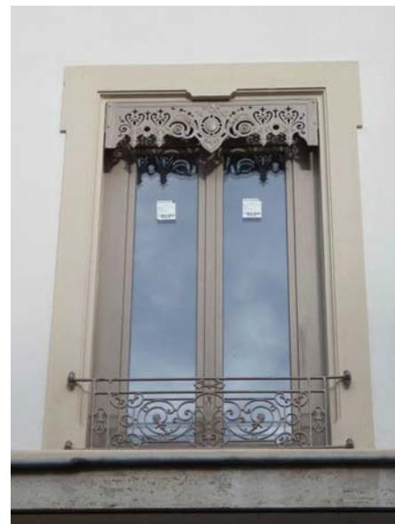
**n° 9** : façade en cours de réfection. Maintien des lambrequins et garde-corps d'origine. Installation de nouvelles jalousies
