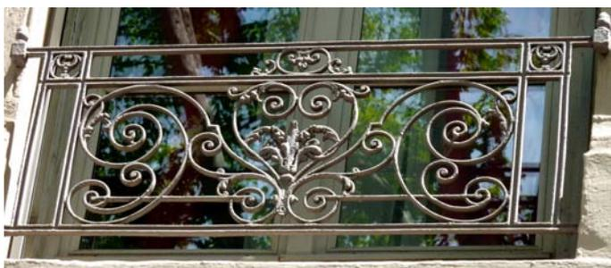
Appui de croisée en fonte : 137 avenue de Saxe. Les cubes de fixation et les gours sur les lisses sont bien visibles.
