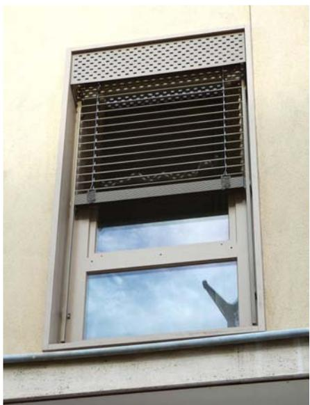
**n° 11** : façade récemment rénovée. Huisseries changées, en aluminium brun foncé. Disparition du garde-corps au profit d'un cadre en verre intégré dans le châssis. Mais réinstallation de jalousies et de lambrequins de facture moderne
