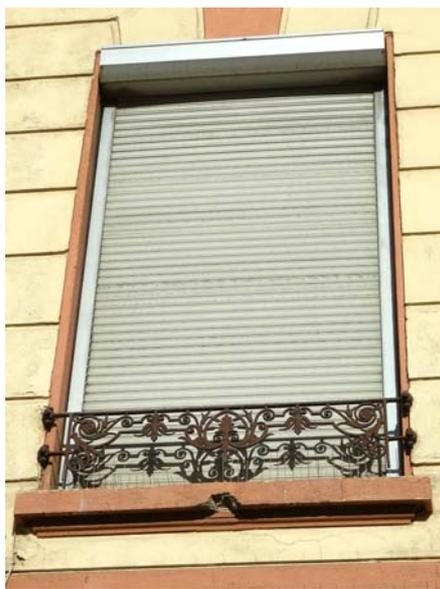
**n° 7** : disparition des lambrequins. Remplacement des jalousies par des volets roulants en aluminium avec caisson en saillie. Maintien des garde-corps
