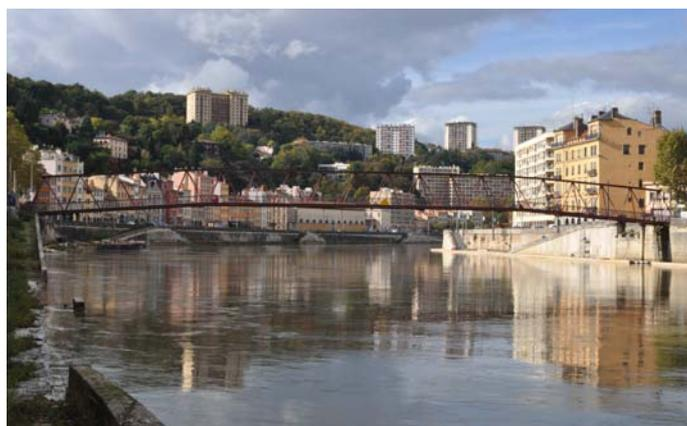
Passerelle de l'Homme de la Roche. Cet ouvrage de construction rustique, lancé à titre provisoire au-dessus de la Saône, doit à son concepteur la rare qualité de présenter une faible empreinte sur le paysage
