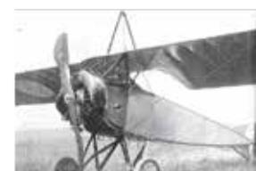
*Morane-Saulnier de Roland Garros équipé d'une mitrailleuse tirant dans l'axe de l'hélice, elle-même pourvue d'un pare-balles*
