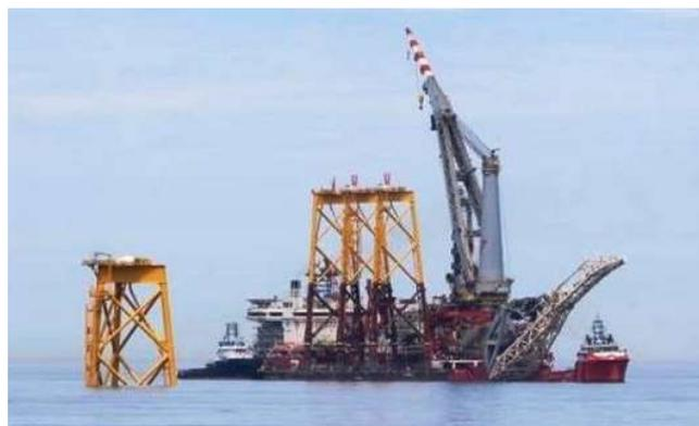
Installation des Jackets par le Seven Borealis. (Photo : Mer et Marine)
