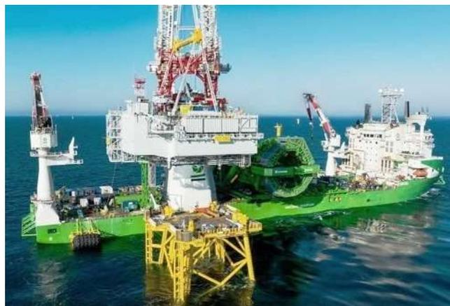
Installation de la sous-station au moyen de l'Orion de Deme. (Photo : DR/Mer et Marine)
