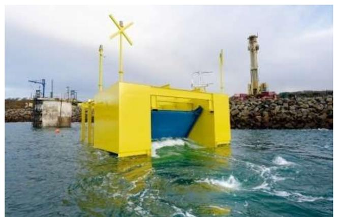
Installation du prototype Dikwe sur le site d'essais en rade de Brest. La première digue portuaire productrice d'énergie au monde, va entrer dans une phase de tests en mer. (Photos : Ifremer)
