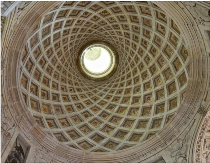
Le dôme, l'un des premiers construits en France, se compose de caissons qui produisent une grande impression de hauteur et de légèreté. Le pavement en marbre précieux reproduit exactement le dessin en projection des caissons du dôme.
