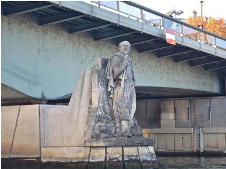
Le zouave du pont de l'Alma qui servait d'instrument de mesure des crues de la Seine (aujourd'hui la mesure est prise du pont de la Tournelle)
