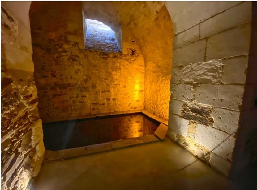
Long de 250 mètres, un souterrain en eau, ingénieux ouvrage civil, permettait de dériver les eaux de la rivière Aubance en cas de crue lors de sa traversée du parc, afin d'éviter que ne soient inondés les parterres. Habilement mis en lumière, sa voûte de schiste se reflète, intacte, dans l'eau de son canal d'ardoise.
