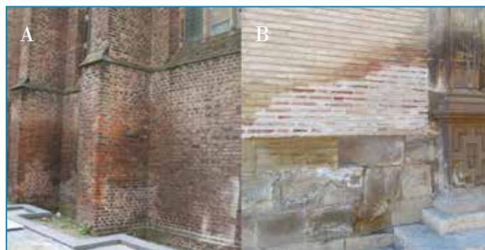
Fig. 1 : Dommages induits par de l'humidité : (A) humidité dans la maçonnerie d'une église provoquant la dégradation des briques. © J. Desarnaud ; (B) cristallisation de sel à la surface d'une façade suite à des remontées capillaires, provoquant des efflorescences et la formation d'écaillés (Mairie de Huesca, Espagne). © H. Derluyn.
