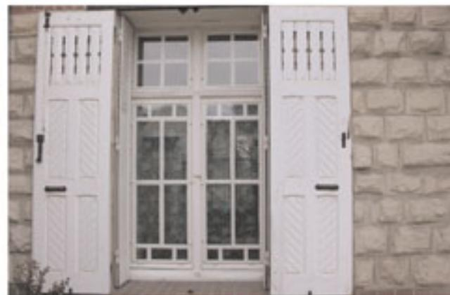
Les joints assurent l'étanchéité de l'ensemble appareillé : pas de joint en creux ni en saillie. On utilise la chaux grasse\*. La teinte du mortier\* se rapproche du ton de la pierre. Sur un mur en pierre de taille, les joints sont minces et discrets. Sur une façade traitée en bossage\*, le joint est très présent de par son relief et son ombre en mortier bâtard\*.
