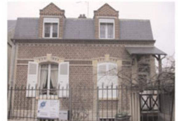
L'appareillage de la brique est réalisé pour créer un parement décoratif, ou associé à des éléments en pierre. On trouve la brique ancienne cuite au charbon, d'une teinte orangée, la brique cuite au charbon, d'une teinte rouge violacé assez unie, les briques colorées ou vernissées, la brique silico-calcaire de couleur claire, associée à la brique rouge.
