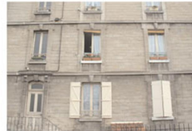
Ces constructions en béton supportent des revêtements variés : revêtement plastique, peinture, pierre plaquée ou (*briquette*), pâte de verre, granité... Les toitures sont souvent des toitures-terrasses qui doivent être révisées avant un ravalement afin d'éviter tout risque d'infiltration.
