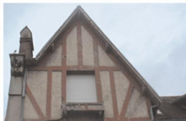
Certains moellons gélifs doivent être protégés par un enduit à base de chaux\*. Si les pierres sont de bonne qualité, on peut réaliser un enduit à pierres vues\*.
