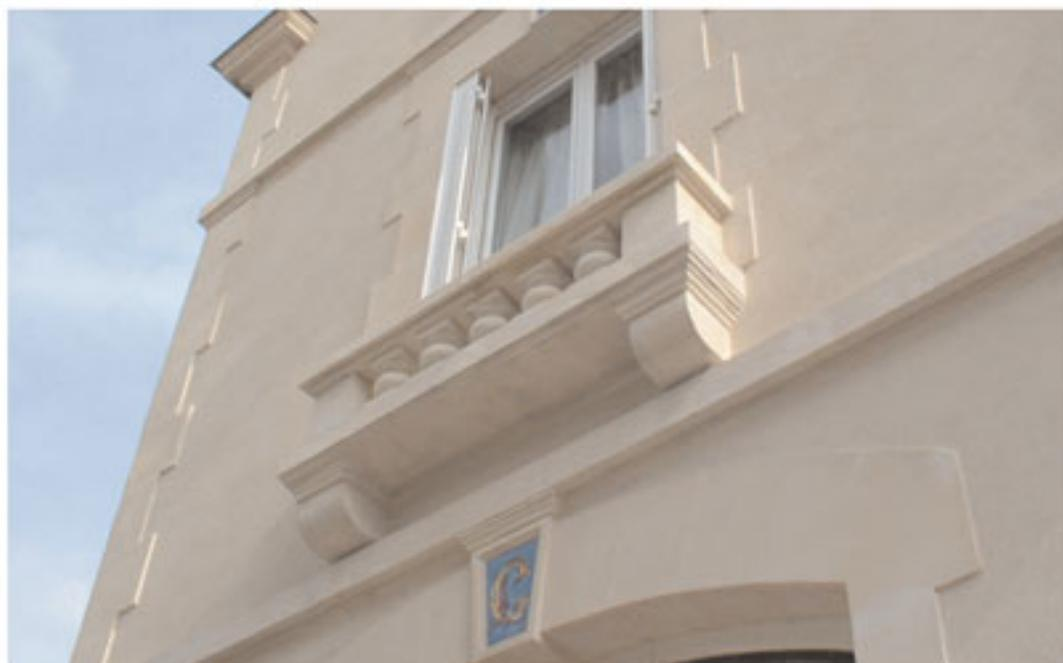
L'enduit plâtre\* recouvre les murs de moellons\*. Il adhère parfaitement et laisse respirer la maçonnerie (*au contraire des revêtements étanches qui laissent l'humidité stagner dans les murs*).
