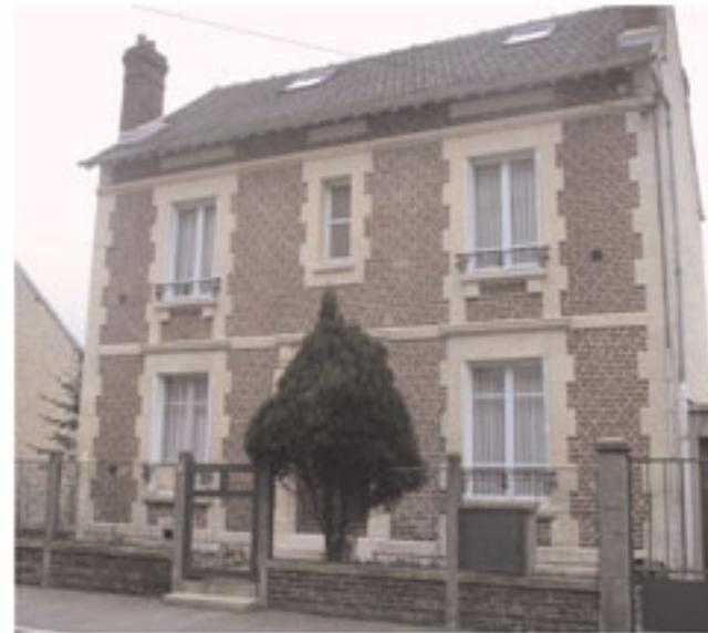
La brique est généralement laissée apparente. Elle est employée en alternance pour constituer le décor des linteaux\*, des encadrements, des corniches\*. Ses dimensions traditionnelles sont 5cm x 10cm x 20cm. Les joints sont effectués avec un mortier\* chaux\* et sable. La brique peut être recouverte d'un badigeon\* ou d'un lait de chaux lorsque l'appareillage ou la qualité ne sont pas parfaites.
