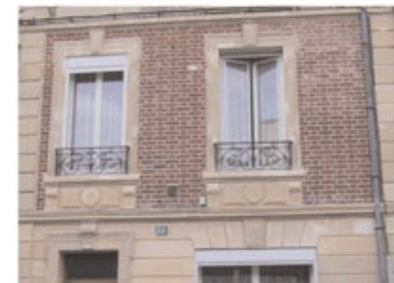
Si les murs sont en pierre (*bosselée, moellon, taille...*), les encadrements de baies, les linteaux\*, les appuis de fenêtres, les lucarnes, les harpes\*, les bandeaux\*, les corniches\* sont en brique. Les murs pignon sont parfois montés en moellon\*. Les murs des maisons en brique et pierre peuvent être composés de nervures en pierre de taille avec tapisserie en brique. Ces parements nobles sont destinés à rester apparents.
