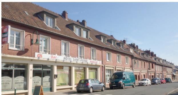
*Cet exemple présente un rythme ordonné entre l'étage et le rez-de-chaussée. Une fenêtre est située dans l'axe de chaque percement de baie. Toutes les baies de largeur identique et composant la devanture constituent une belle surface de vitrine.*
