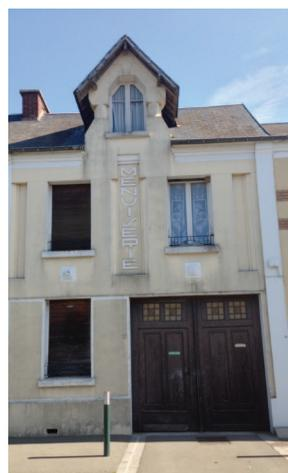
**CONSEIL : respect du système constructif : il est important de prendre en compte les axes et éléments constructifs pour l'organisation des percements d'une façade en faisant coïncider les axes des surfaces vitrées avec les ouvertures de l'étage : la composition générale de l'immeuble est ainsi préservée.**
