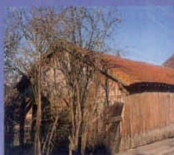
Le remplissage des pans de bois était généralement réalisé en torchis et recouvert d'un enduit à la chaux. Ce torchis armé d'un lattis de bois, ne participe pas, en principe, à la solidité de l'ouvrage dont l'équilibre statique est assuré totalement par l'ossature en bois. Parfois les murs exposés à l'ouest sont protégés des intempéries par un bardage.
