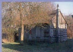
Le bardage assure la ventilation du mur et peut se présenter sous la forme d'essentage et de clins : planches régulières en bois disposées horizontalement, avec un léger recouvrement.
