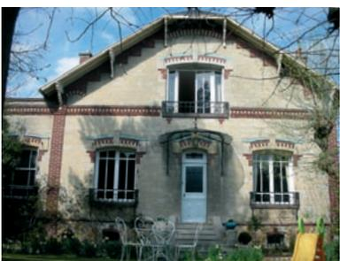
La tuile mécanique, l'ardoise, le zinc, la pierre meulière ou calcaire, l'enduit ciment sont les matériaux traditionnels de ces maisons. La brique en argile de ton rouge, silico-calcaire de teinte claire, vernissée de couleur est posée en alternance et constitue le décor des corniches, des linteaux, des appuis, des encadrements, des bandeaux.
