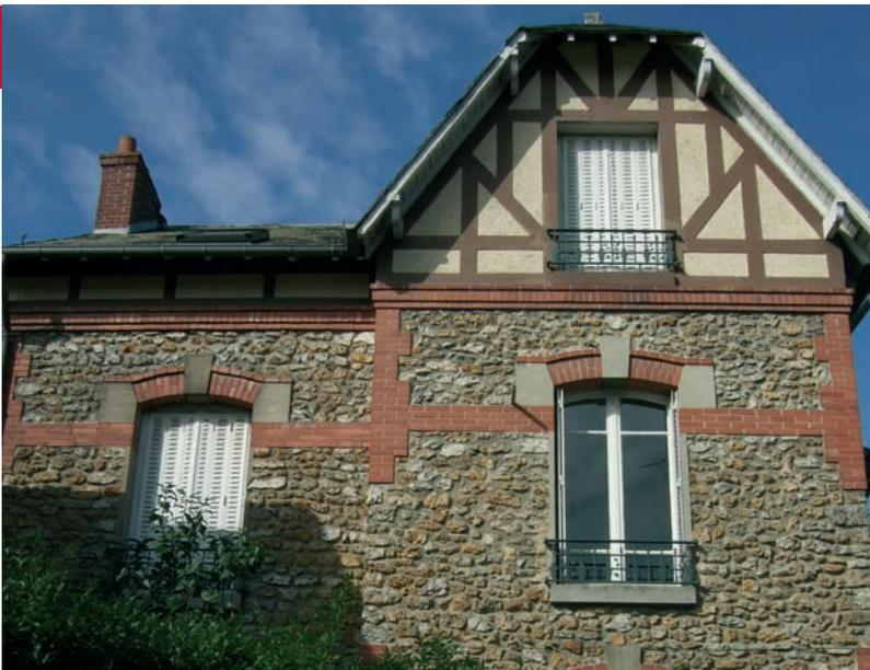
Les façades des maisons 19<sup>ème</sup> sont composites alliant la pierre, la brique, le béton et les faux pans de bois en enduit. Les débords de toiture avec les éléments en bois protègent les murs. Les ouvertures fermées par des persiennes métalliques pliantes sont agrémentées de ferronneries.
