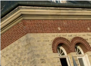
Sur les murs de moellon, harpe, chaînage d'angle en pierre de taille et en brique viennent renforcer la maçonnerie en calcaire.
