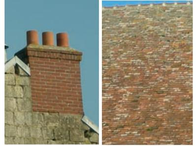
Les couvertures traditionnelles de Boran-sur-Oise sont en tuile plate de petit moule (60 à 80 au m<sup>2</sup> environ), le faîtage est scellé au mortier clair avec des tuiles demi-rondes (faîtage à crêtes et embarrures). Les rives sont souvent protégées par un solin de plâtre appelé la ruellée. Celle-ci empêche la pluie de s'infiltrer sous la toiture.
