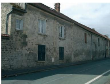
La construction forme un parallélogramme rectangle sur deux niveaux, surmonté d'un toit à deux pans dont la pente est de 45°. La toiture est généralement encadrée par des souches de cheminée établies dans le prolongement des pignons.
