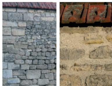
Les murs en pierre sont montés avec de la pierre de taille et du moellon calcaire trouvés dans les terres cultivées de Boran-sur-Oise. Ils sont parfois montés avec très peu de mortier avec un aspect proche de celui de la pierre sèche. Des rangs de tuile mécanique les protègent des intempéries.
