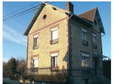
Les ouvertures ordonnancées sur les murs sont diverses par leur forme et leur dimension : lucarne, baie cintrée, large percement à meneaux... Les linteaux parfois cintrés, métalliques ou en pierre et brique, sont alignés horizontalement.
