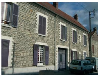
Les murs sont en pierre calcaire, les couvertures en tuile plate. Corniche, bandeaux et encadrements sont généralement en plâtre. Ces modénatures peuvent aussi être en enduit lissé.
