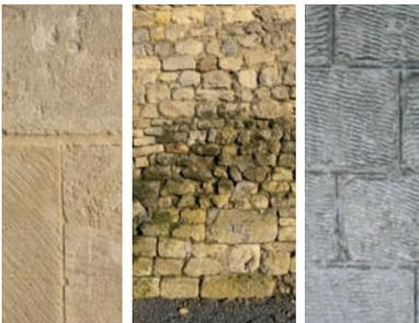
Les murs, les piles réalisés en pierre de taille ne sont pas enduits, laissant visible l'appareillage et les joints au mortier de chaux. Certaines pierres ont une finition bourchardée.
