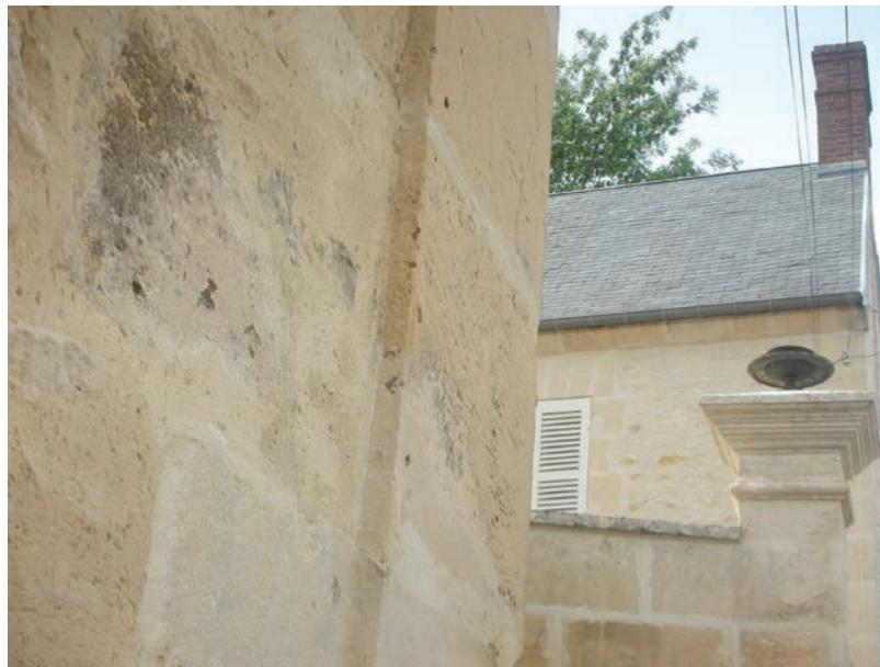
Les enduits sont appliqués soit partiellement (enduit de restauration à pierre-avec des joints arasés au nu de la maçonnerie), soit totalement (enduit couvrant au mortier de chaux ou au plâtre, selon les cas).
