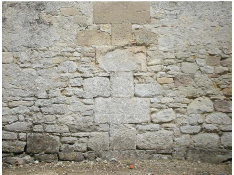
Sur les murs de moellon, chaînages, encadrements et appuis de fenêtre, en pierre de taille, structurent la maçonnerie. Les chaînes des hauts murs sont constituées par des blocs de grandes dimensions. Les encadrements en pierre renforcent les ouvertures dans les murs, facteurs de fragilité.
