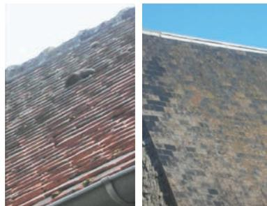
Les couvertures traditionnelles de Brasseuse sont en tuile plate de petit moule (60 à 80 au m<sup>2</sup> environ), le faîtage est scellé au mortier clair avec des tuiles demi-rondes (faîtage à crêtes et embarrures).
