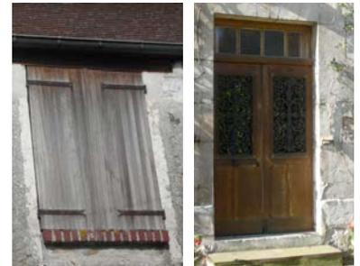
Les volets battants des fenêtres s'encastrant dans les feuillures ménagées à l'extérieur des tableaux.
