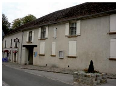
Les murs sont montés en moellon de grès ou, plus rarement, de calcaire, avec peu de harpes malgré leur longueur. Traditionnellement, ils étaient enduits jusqu'au sol. Respirants, sains pour les maçonneries, les enduits étaient entretenus régulièrement. Contrairement à d'autres maisons, les maisons de ferme ont souvent conservé cette protection.
