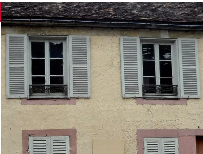
Les éléments de ferronnerie sont souvent présents sur les façades des maisons d'Ermenonville : garde-corps aux fenêtres des étages, grilles de protections de fenêtres aux rez-de-chaussée... Ces éléments en fer forgé et en fonte peuvent prendre la forme d'ouvrages élaborés avec des représentations symboliques et contribuent, comme le style des fenêtres, à créer l'identité de la façade.
