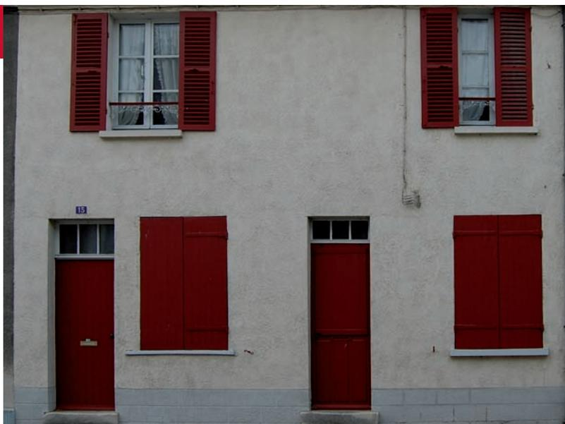
Les volets sont en bois, réalisés avec des planches verticales assemblées par des barres horizontales sans écharpe.
