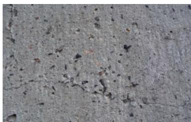
La couleur d'un enduit dépend de la qualité de la pierre cuite pour obtenir le plâtre (gypse) ou la chaux (calcaire), de la teinte et du grain du sable et des pigments minéraux qui peuvent être ajoutés. Les enduits à base de ciment ne sont apparus qu'au siècle dernier et ne s'adaptent pas aux murs maçonnés anciens.
