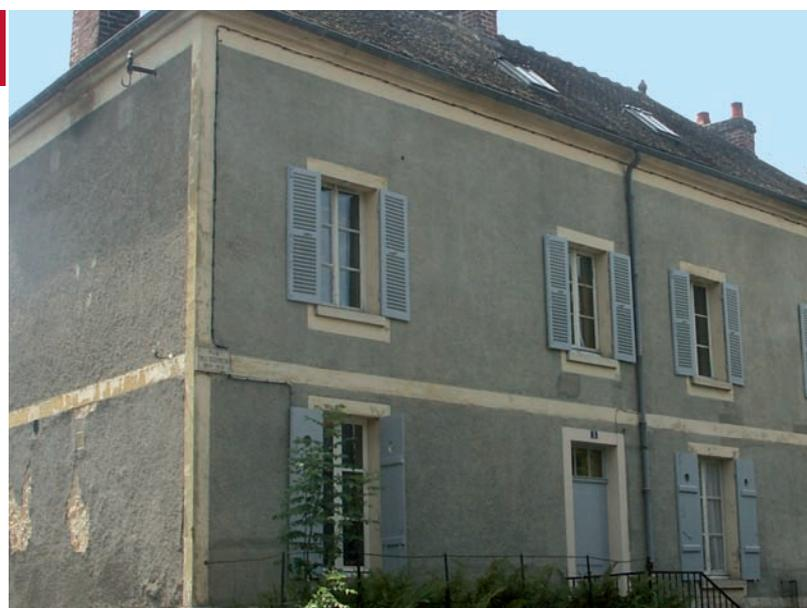
Les corniches, bandeaux et encadrements de baies ont pour rôle d'éloigner l'eau des murs et des ouvertures. Le plus souvent réalisés en plâtre, parfois en pierre ou en brique, le niveau de détails détermine en général le statut social d'origine de la maison. Beaucoup de ces détails ont été supprimés lors de ravalements peu soignés. Leur disparition peut avoir de graves conséquences sur l'état de la façade et du bâtiment en général.
