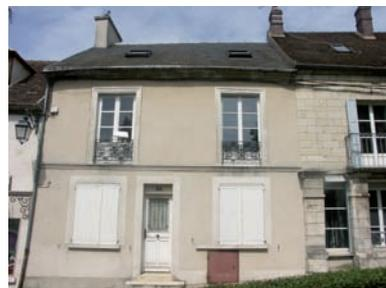
Le matériau de maçonnerie utilisé pour la construction des grandes maisons est le moellon de grès ou de calcaire, enduit au plâtre, coloré dans des teintes allant du rosé au jaune ocre léger. Les bandeaux et corniches sont en plâtre, plus rarement en pierre.
