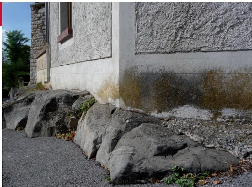
La pierre calcaire est également présente, bien qu'en moindre quantité. Sa teinte claire contraste avec les gris rouges du grès. Le grès, difficile à tailler limite la mise en œuvre d'un bel appareillage régulier. Les éléments des chaînes d'angle sont généralement grossièrement taillés et masqués par un enduit. Le calcaire, plus tendre permet, sous forme de pierre de taille, la mise en œuvre de chaînes et harpes régulières qui restent alors apparentes.
