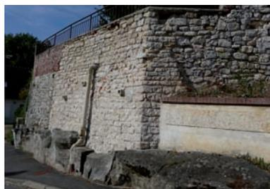
Les pentes les plus abruptes sont travaillées par une succession de murs de soutènement. Des trous d'aération, appelés chantepleures, permettent à l'eau contenue dans le sol de s'échapper sans exercer de pression sur le mur.
