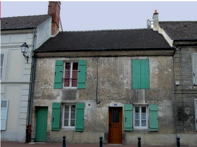
Les souches de cheminées se dressent dans la continuité des murs pignons. Les combles ne sont traditionnellement pas aménagés. Les appuis des fenêtres sont en pierre monolithe et les éléments de modénatures, en plâtre, se limitent dans la plupart des cas à une corniche, parfois accompagnée d'un bandeau marquant la séparation des étages. Certaines maisons présentent des décors plus marqués : enduits teintés ou parements de briquettes.
