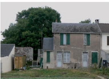
Moellons de grès ou parfois de calcaire montés au plâtre, au sable et à la chaux pour les murs, et tuile plate pour la couverture sont les matériaux de construction principalement utilisés.
