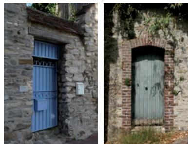
Les portes piétonnières qui donnent accès aux jardins privés peuvent être en bois ou en métal. Les assemblages de ferronnerie ou de bois restent simples. Les encadrements peuvent être en maçonnerie de moellon, de brique ou, plus rarement de pierre de taille.
