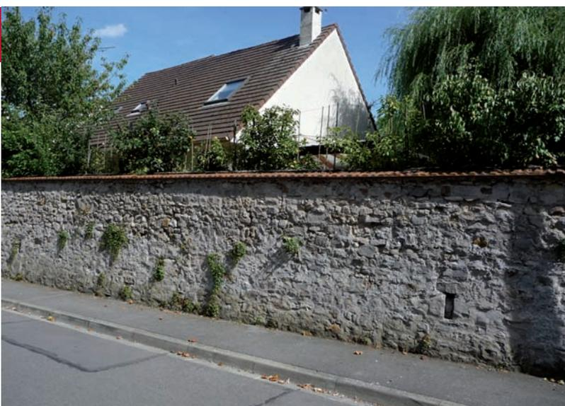
Les murs anciens sont montés avec des matériaux locaux : moellon de grès, mais aussi de calcaire, et brique (élément souvent utilisé lors de réparations ou surélévations). Les joints, recouvrant largement les maçonneries, sont un mélange de terre et sable souvent additionné de plâtre ou de chaux. Les têtes de murs sont protégées par des rangs de tuiles plates, des dalles de pierre en saillie ou un chaperon maçonné. Ils préservent les murs des ruissellements d'eau de pluie.
