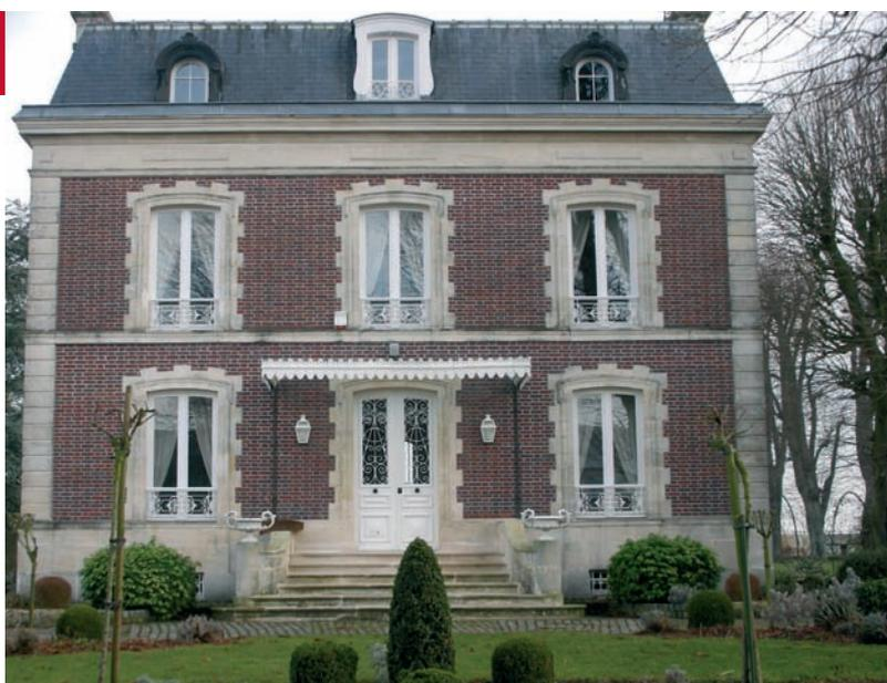
Les façades des grandes demeures sont ordonnancées : alignement horizontal des linteaux et des appuis, superposition et hiérarchisation des fenêtres. La porte d'entrée surmontée d'une marquise présente deux vantaux. La toiture mansardée offre des combles habités éclairés par des lucarnes au profil cintré disposées suivant l'ordonnement de la façade.
