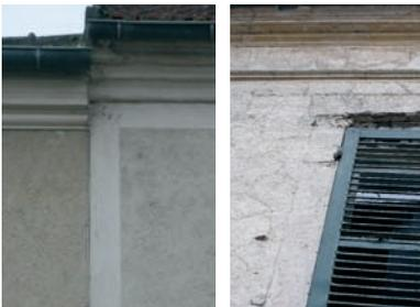
Sur les murs de moellon, appui de fenêtre, harpe et chaînage d'angle en pierre de taille renforcent la maçonnerie en grès et calcaire.
