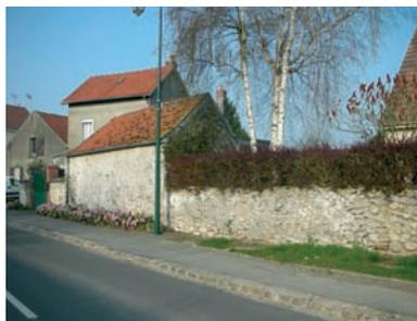
Certains murs de clôture dévoilent un appareillage de qualité composé de moellon assisé, ou de brique.
