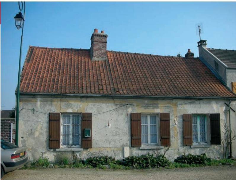
Par leurs couleurs, volets et portes habillent la façade en harmonie avec le ton de l'enduit et de la couverture. Des modénatures en enduit finition lissée ornent la longère. Traditionnellement inhabité, le comble est éclairé par une lucarne à engranger quand un étage à encuvement existe.
