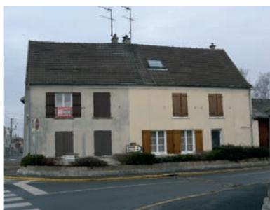
La tuile plate et le moellon calcaire souvent encore enduit sont les matériaux traditionnels des maisons de village. De gros blocs de grès consolident les murs formant notamment le chaînage. Des corniches, des bandeaux et des appuis de fenêtre structurent les façades. On observe des linteaux de bois recouverts à l'origine.
