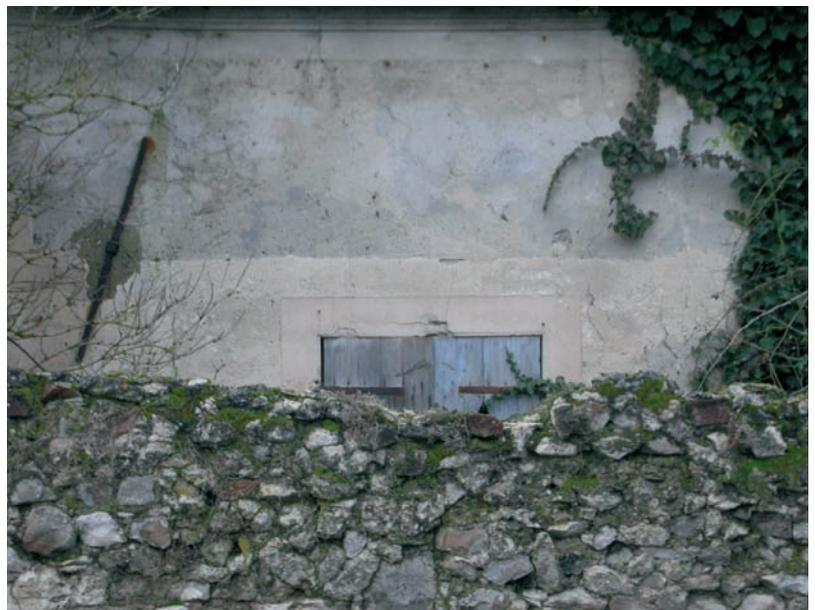
Les ouvertures dans les murs, facteurs de fragilité, font l'objet de nombreux détails soignés. Les pierres du soubassement (rarement à vue) sont recouvertes par un enduit lissé serré pour protéger le pied du mur des infiltrations et des rejaillissements d'eau pluviale.
