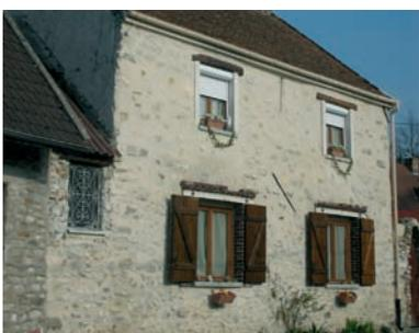
La tuile plate, le grès et le moellon calcaire enduit sont les matériaux de construction traditionnels des maisons rurales. Les pignons sont recouverts d'un enduit à pierre vue.
