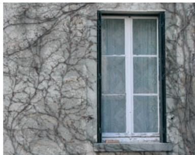
Les fenêtres des grandes demeures sont plus grandes que les fenêtres courantes (environ 1m x 1m75). Leurs dimensions peuvent décroître avec les étages. Des menuiseries à petits carreaux caractéristiques du XVIII<sup>ème</sup> siècle subsistent rarement.
