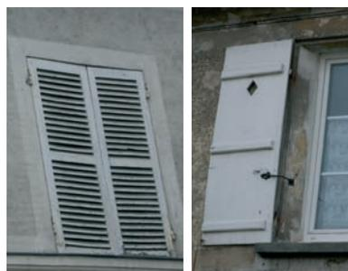
Les volets battants des fenêtres s'encastrent dans les feuillures ménagées à l'extérieur des tableaux. Ils sont réalisés en bois peint non verni sous forme de planches assemblées par des barres horizontales sans écharpe.
