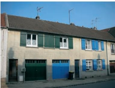
La construction forme un parallépipède rectangle sur deux niveaux dont un encuvement, surmonté d'un toit à deux pans entre 35 et 45°, rythmé par des souches de cheminée en brique.
