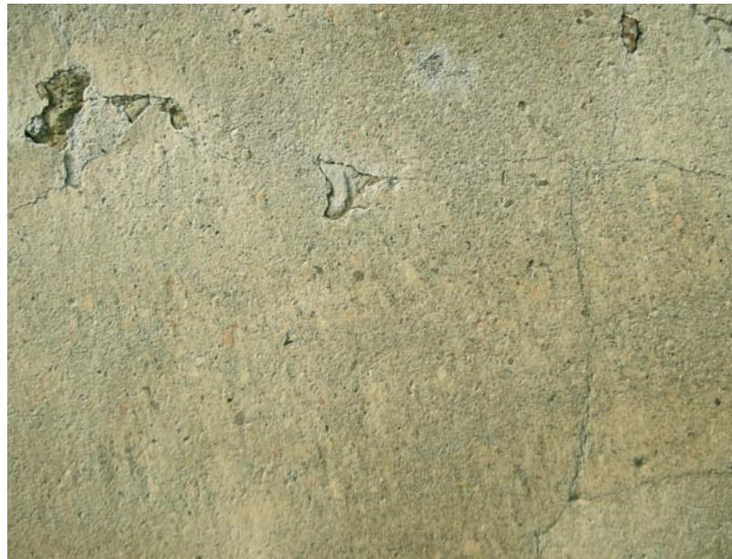
A l'origine, les enduits étaient appliqués totalement en particulier sur les moellons calcaires gélifs (enduit couvrant au mortier de chaux grasse mélangé avec du plâtre gros). Parfois, ces enduits sont teintés en ocre rouge, ocre jaune... Quelques têtes saillantes de moellon restent visibles sur certains murs rejointoyés à la chaux.
