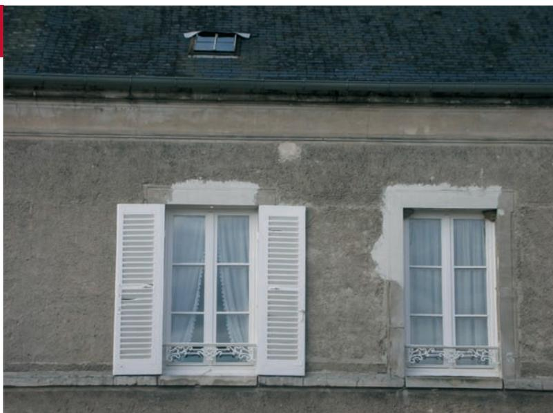
Des éléments de ferronnerie sont parfois présents sur les fenêtres des façades de Montagny-Sainte-Félicité. On note des garde-corps à l'étage des maisons. Ils prennent la forme de simple lice ou d'ouvrage en fer forgé et en fonte. Des feuillures permettent d'encastrer les volets dans le tableau afin qu'ils ne donnent pas prise au vent. Des encadrements en enduit lissé ornent les baies.
