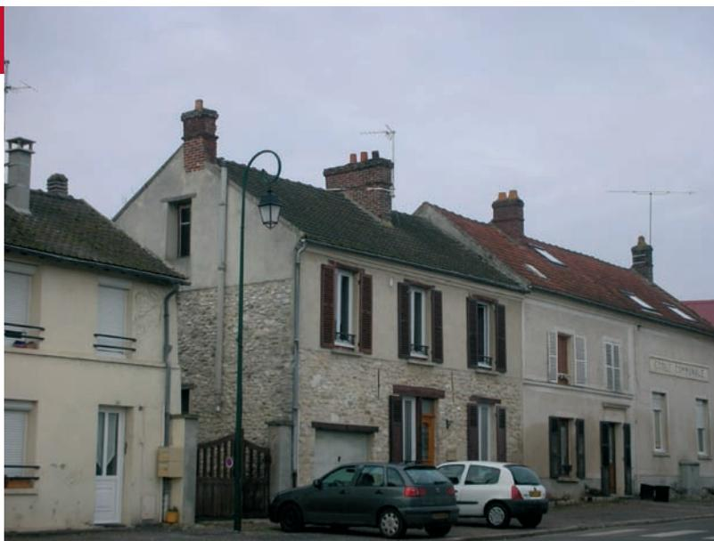
Les façades des maisons de village étaient toujours protégées par un enduit plâtre chaux. Des modénatures en enduit finition lissée ornaient les murs sur rue. Les ouvertures fermées par des volets persiennés en bois sont agrémentées de ferronneries.
