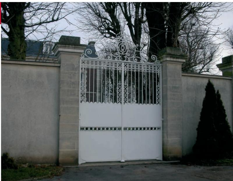
Les portails et les portes piétonnières présentent un profil droit de même hauteur que les murs. Ils sont en bois ou en métal à barreaudage vertical avec éventuellement des plaques pleines et s'accordent avec la grille de clôture en ferronnerie.
