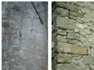
Les murs, les piles, ou parties de façade réalisés en bloc de grès ou en pierre de taille non gélifs ne sont pas enduits, laissant visible l'appareillage et la finesse des joints au mortier de chaux.
