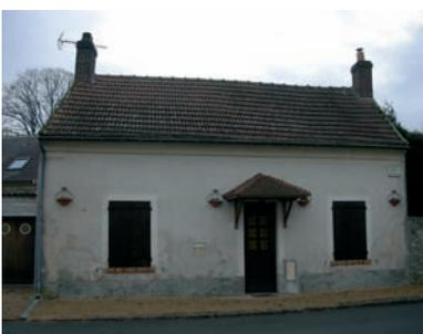
La tuile plate, le grès et le moellon calcaire enduit sont les matériaux de construction traditionnels des longères. Certains pignons sont montés avec une mise en œuvre dont l'aspect s'apparente à celui de la pierre sèche. On observe des corniches en plâtre ou en pierre et des encadrements en enduit lissé.
