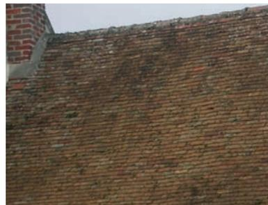
Les couvertures traditionnelles de Montagny-Sainte-Félicité sont en tuile plate de petit moule (60 à 80 au m<sup>2</sup> environ), le faitage est scellé au mortier clair avec des tuiles demi-rondes (faitage à crêtes et embarrures).
