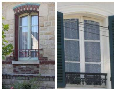
Des feuillures permettent d'encastrer les volets dans le tableau afin qu'ils ne donnent pas prise au vent.
