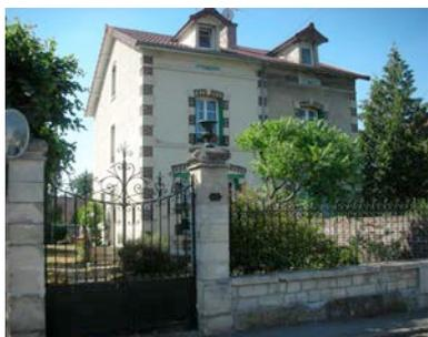
La tuile mécanique, le zinc, la brique, le moellon bosselé, la pierre de taille sont les principaux matériaux des maisons 1900. Les modénatures sont en pierre de taille ou en brique silico-calcaire ou vernissée. Le soubassement généralement en pierre de taille se terminant par quelques rangs de brique, en ressaut, protège le mur des rejaillissements d'eau.
