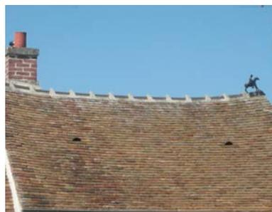
Les couvertures traditionnelles d'Orry-la-Ville sont en tuile plate de petit moule (60 à 80 au m<sup>2</sup> environ), le faitage est scellé au mortier clair avec des tuiles demi-rondes (faitage à crêtes et embarrures).
