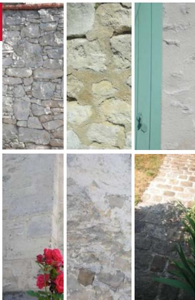
Les murs, les piles ou parties de façade réalisés en pierre de taille, brique ou moellon équarri non gélif ne sont pas enduits, laissant visible l'appareillage et les joints au mortier de chaux. Certaines pierres ont une finition layée ou bosselée.
