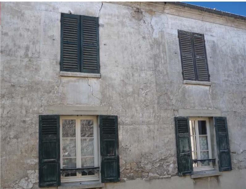
Les volets battants des fenêtres s'encastrent dans les feuillures ménagées à l'extérieur des tableaux. Ils sont réalisés en bois peint parfois métalliques pliants, persiennés sur la moitié de leur hauteur au rez-de-chaussé et en totalité à l'étage. Parfois, ils sont sous forme de planches assemblées par des barres horizontales sans écharpe.
