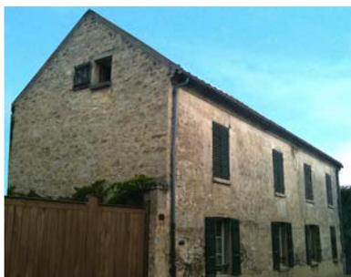
La tuile plate, le moellon calcaire enduit et la pierre de taille sont les matériaux de construction traditionnels des maisons de bourg.
