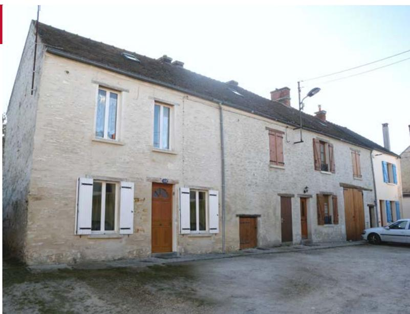
Les façades des maisons de bourg étaient toujours protégées, du haut jusqu'à la base du mur, par un enduit plâtre chaux avec une finition lissée. Les tableaux des baies, les linteaux, les chaînages d'angle sont structurés par de grosses pierres rarement apparentes.
