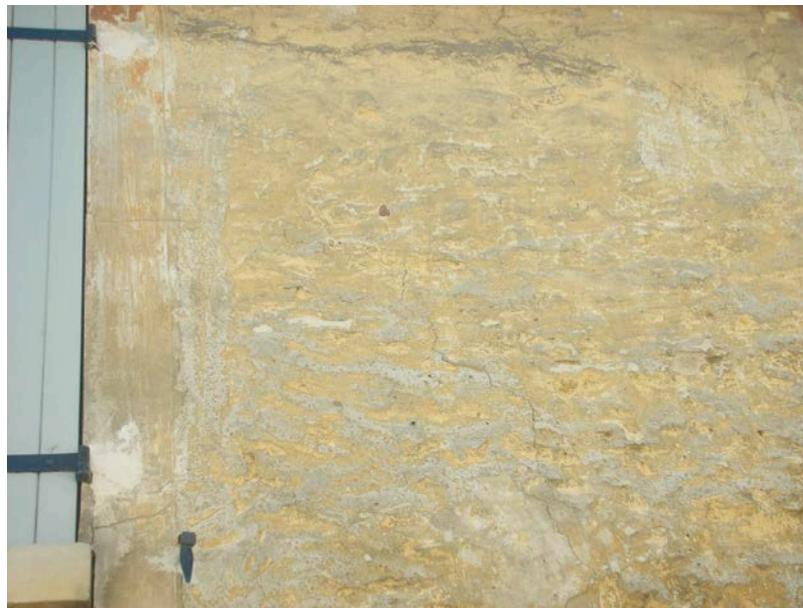
A l'origine, le moellon devait être totalement recouvert par un enduit (couvrant au mortier de chaux parfois mélangé avec du plâtre gros selon les cas) pour protéger et apporter de la couleur aux façades. Ces enduits peuvent être teintés en ocre rouge, ocre jaune... Quelques têtes saillantes de moellon restent visibles sur certains murs rejointoyés à la chaux.
