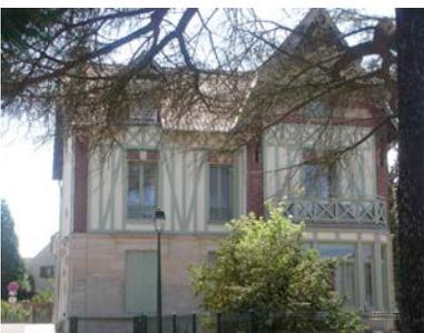
Les grandes maisons sont construites en pierre de taille ou moellon calcaire. Les parties en moellon sont recouvertes par un enduit lissé qui protège les murs depuis le haut jusqu'à la base.
