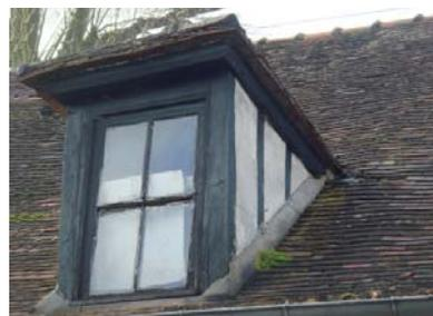
Les lucarnes, quand elles existent, sont en maçonnerie ou en bois, en zinc ou en plomb, recouvertes de tuiles. Elles présentent des formes variées sur les villas.
