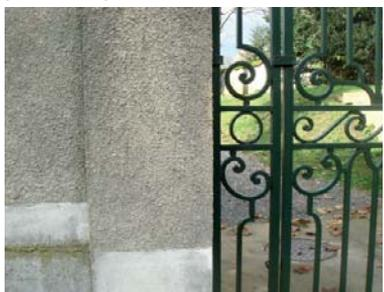
En façade, le moellon gélif est recouvert d'un enduit qui le protège et peut apporter de la couleur aux façades. A l'origine, les enduits étaient appliqués totalement (couvrant au mortier de chaux aérienne parfois mélangé avec du plâtre gros, selon le cas). Les murs de clôture en grès étaient montés à pierre vue.
