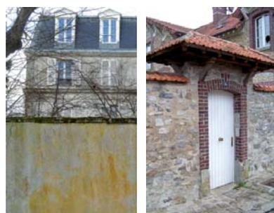
La couleur du mortier se rapproche de celle de la pierre. Elle prend une plus grande importance visuelle sur les murs en moellons que sur les murs en pierre de taille où les joints sont minces et à peines apparents. La brique réhausse leur aspect de touches brun-rouge.
