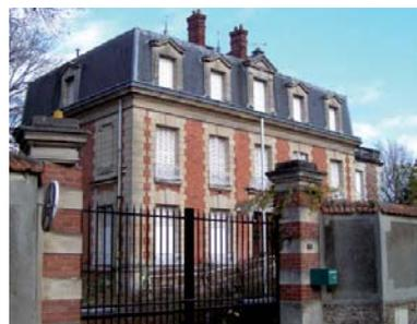
Les ouvertures sont ordonnancées : alignement horizontal des linteaux et des appuis, superposition et hiérarchisation des fenêtres élancées.
