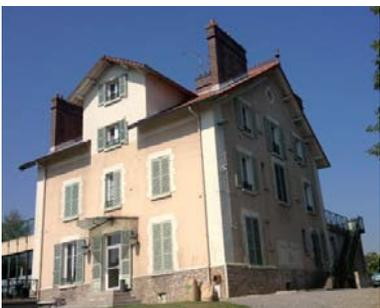
La tuile mécanique, l'ardoise, le zinc, la pierre calcaire (de taille, en moellon, équarrie, bosselée, layée), l'enduit sont les matériaux de construction traditionnels des villas. Les corniches, bandeaux, encadrements et appuis sont en pierre, en brique, ou recouverts d'enduit.
