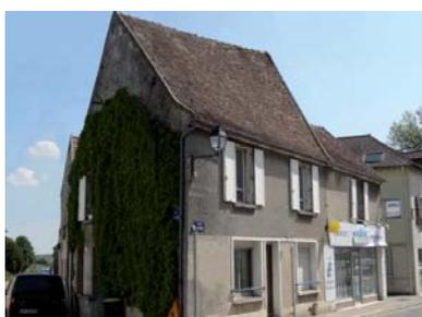
La construction forme un parallélogramme rectangle sur deux niveaux hauts. Elle est surmontée d'un toit à deux ou quatre pans entre 35° et 50°, parfois encadré par des souches de cheminée massives.
