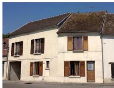
Les ouvertures sont disposées avec ordonnancement : alignement horizontal des linteaux et des appuis, superposition et hiérarchisation des fenêtres. Plus hautes que larges, elles laissent entre elles des parties verticales de mur plein appelées trumeaux.
