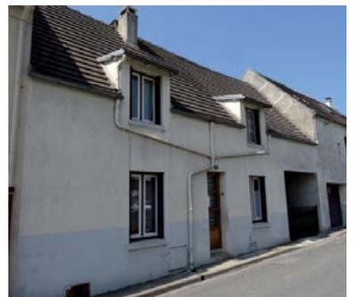
Portes et fenêtres n'occupent qu'une surface réduite de la façade, laissant entre elles d'importantes parties verticales de mur plein, appelées trumeaux. Leurs linteaux et appuis sont généralement alignés horizontalement.
