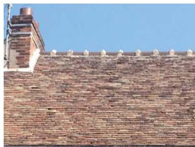
Les couvertures traditionnelles de Plailly sont en tuile plate de petit moule (60 à 80 au m<sup>2</sup> environ); le faîtage est scellé au mortier clair avec des tuiles demi-rondes (faîtage à crêtes et embarrures).
