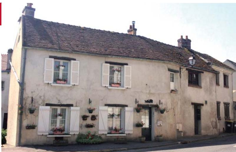
La façade de la maison rurale comporte généralement trois travées : deux travées de fenêtres superposées et une travée pour la porte d'entrée surmontée d'une petite fenêtre.
