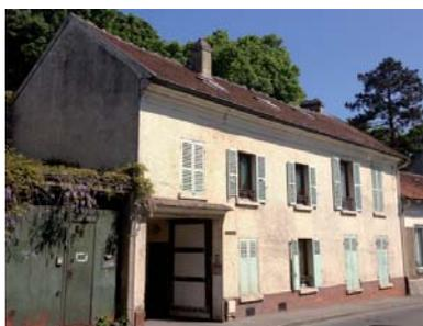
La construction forme un parallépipède rectangle sur deux niveaux de hauteur différente, surmonté d'un toit à deux pans entre 35° et 45°, parfois encadré par des souches de cheminée en brique.
