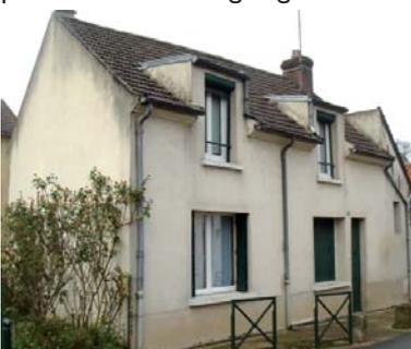
La tuile plate et le moellon calcaire enduit sont les matériaux de construction traditionnels des maisons "de ferme".
