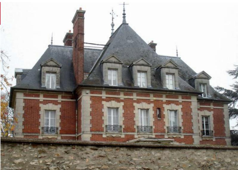
Chaque villa se singularise par ses matériaux - comme les faux pans de bois enduit (rechampissage) - par ses ouvertures aux formes et dimensions variées, par sa toiture - avec des croupes (pan rampant à l'extrémité d'un comble) des noues, des brisis, des avancées, des débords, des coyaux, des jambettes (éléments de charpente prolongeant le toit), des épis de faitage.
