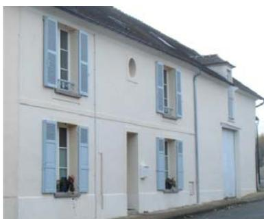
La tuile plate et le moellon calcaire enduit sont les matériaux de construction traditionnels des maisons rurales. Les modénatures - corniche, bandeaux, chaînages - sont en plâtre. Les encadrements sont en moellon avec enduit lissé.
