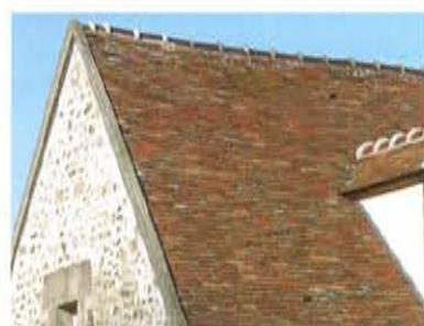
Les couvertures traditionnelles de ce village sont en tuiles plates de petit moule (60 à 80 au m<sup>2</sup> environ), le faîtage est scellé au mortier clair avec des tuiles demi-rondes (faîtage à crêtes et embarrures). Les rives sont souvent protégées par un solin de plâtre appelé la ruellée. Celle-ci empêche la pluie de s'infiltrer sous la toiture.
