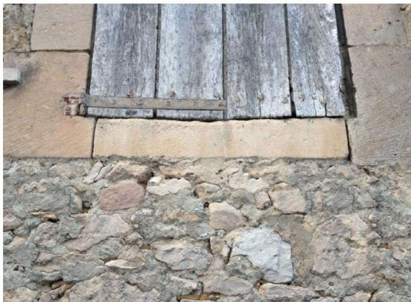
Les ouvertures dans les murs, facteurs de fragilité, font l'objet de nombreux détails soignés : taille, forme, matériau, finition, appareillage...
