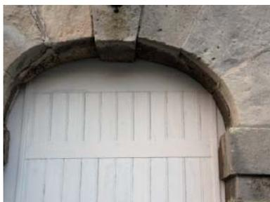
Quand les encadrements, les appuis de fenêtre, les bandeaux sont en pierre de taille appareillée, ils ne sont pas enduits.
