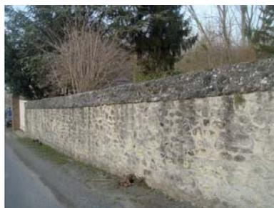
Les murs sont construits en pierre de taille, en moellon calcaire et/ou en grès. Ils sont protégés par un chaperon en tuile, en pierre de taille ou en maçonnerie enduite.
