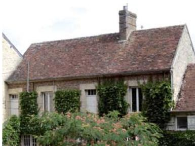
La tuile plate, le zinc, la brique et la pierre de taille sont les matériaux de construction traditionnels des maisons 19<sup>ème</sup> brique et pierre à Rhuis. Certains murs de pignon en moellon sont montés à pierre vue.
