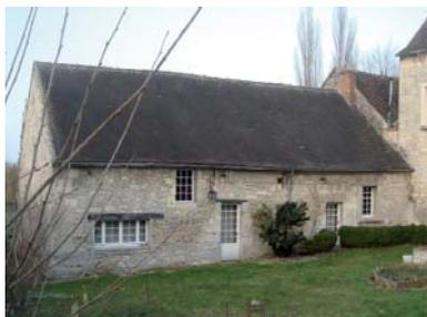
La tuile plate, le moellon calcaire enduit et la pierre de taille sont les matériaux de construction traditionnels des maisons rurales.
