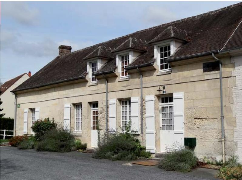
Par leurs couleurs, volets et portes agrémentent la façade en harmonie avec le ton de la pierre. Harpes, encadrements, enduit ou pierre de taille, ornent la longère. Traditionnellement inhabité, le comble n'était éclairé que par des châssis à tabatière de petites dimensions, ou, dans le cas d'un étage à encuvement, par des lucarnes à engranger souvent fermées par un contrevent.
