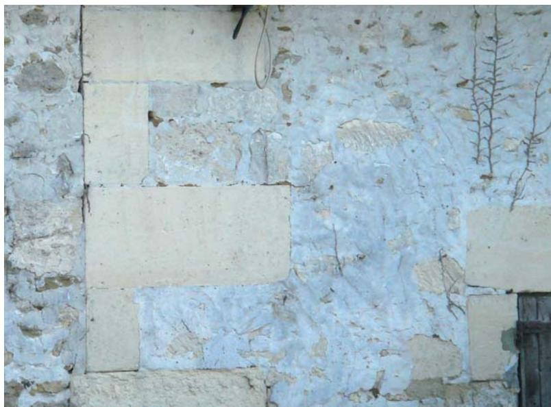
Le moellon gélif est recouvert d'un enduit qui le protège et apporte de la couleur aux façades. A l'origine, les enduits étaient appliqués totalement (couvrant au mortier de chaux aérienne parfois mélangé avec du plâtre gros). Les murs de clôture en grès étaient enduits à pierre vue.
