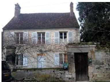
Les ouvertures sont disposées avec ordonnancement : alignement horizontal des linteaux et des appuis, superposition et hiérarchisation des fenêtres.
