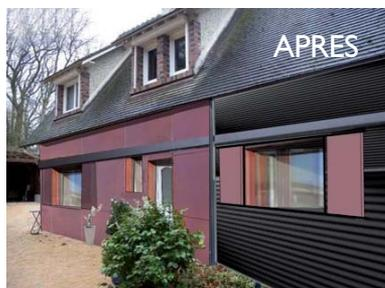
Une isolation par l'extérieur, permet d'actualiser aussi l'image de l'habitation ; veiller cependant à conserver l'écriture caractéristique initiale de la maison : débords de toiture, épaisseur des appuis de fenêtres, empattement ou retrait du soubassement
