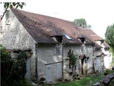
La tuile plate et le moellon calcaire enduit sont les matériaux de construction traditionnels des longères.
