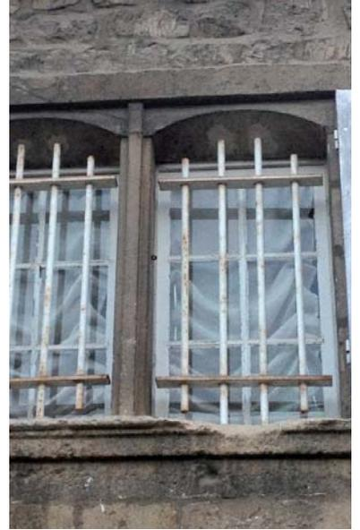
Des barreaudages posés en tableau, sécurisent les fenêtres des rez-de-chaussée.
