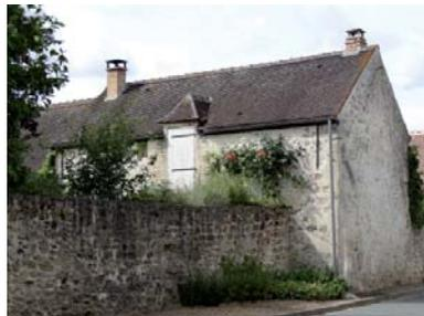
L'étage, à encusement, n'est éclairé que par une ouverture à engranger se fermant par un contrevent en bois.
