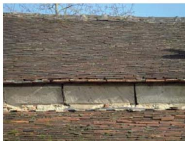
Les couvertures traditionnelles de Rhuis sont en tuile plate de petit moule (60 à 80 au m<sup>2</sup> environ) ; le faîtage est scellé au mortier clair avec des tuiles demi-rondes (faîtage à crêtes et embarrures).
