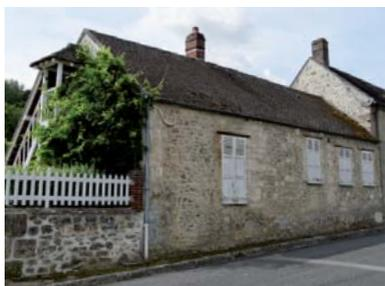
La construction forme un parallépipède rectangle surmonté d'un toit à deux pans entre 35° et 45°.
