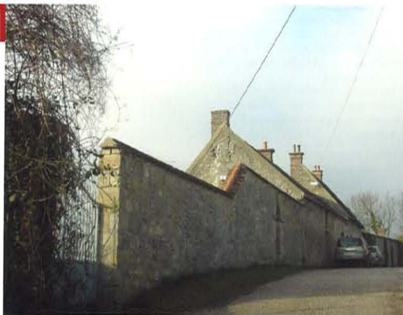
Ces murs sont très ouvragés : tête de mur réalisée par un chaperon convexe de moellons ou une dalle de pierre en saillie, rangs de tuiles plates pour rejeter les eaux de pluie. Lorsque les murs présentent une certaine longueur, des jambes harpées et des chaînages aux angles les consolident.
