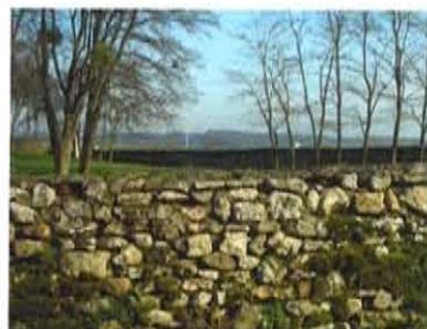
Les murs en pierre sont montés traditionnellement avec des moellons trouvés dans les terres cultivées de Villeneuve. Ils peuvent être enduits ou non, parfois montés avec très peu de mortier avec un aspect proche de celui de la pierre sèche.
