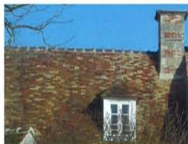
Les couvertures traditionnelles de Villeneuve sont en tuiles plates de petit moule (60 à 80 au m<sup>2</sup> environ), le faîtage est scellé au mortier clair avec des tuiles demi-rondes (faîtage à crêtes et embarrures). Les rives sont souvent protégées par un solin de plâtre appelé la ruellée. Celle-ci empêche la pluie de s'infiltrer sous la toiture.
