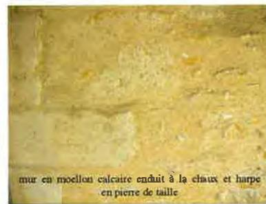
mur en moellons calcaire enduit à la chaux et harpe en pierre de taille
