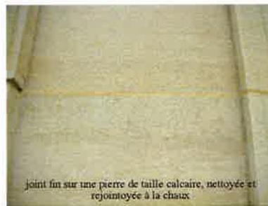
joint fin sur une pierre de taille calcaire, nettoyée et rejointoyée à la chaux
