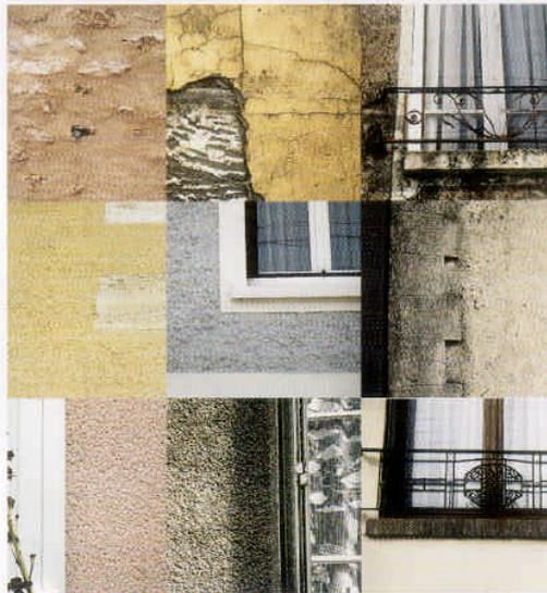
L'enduit plâtre recouvre les murs de moellons. Il adhère parfaitement et laisse respirer la maçonnerie (*au contraire des revêtements étanches qui laissent l'humidité stagner dans les murs\**).
