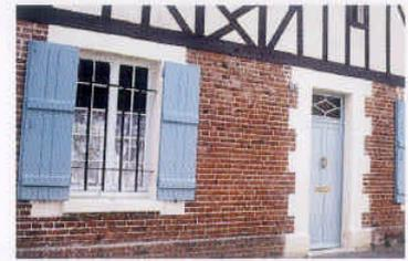
Les briques défectueuses sont remplacées par des blocs de même origine, ou à défaut, de même teinte. **Ne pas utiliser des briques "léopard"** aux teintes mélangées allant du jaune au brun violet, étrangères aux tonalités locales.
