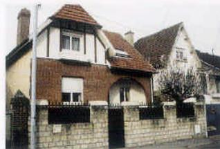
L'appareillage de la brique est réalisé pour créer un parement décoratif, ou associé à des éléments en pierre. On trouve la brique ancienne cuite au feu de bois, d'une teinte orangée, la brique cuite au charbon, d'une teinte rouge violacé assez unie, les briques colorées ou vernissées, la brique silico-calcaire de couleur claire, associée à la brique rouge.
