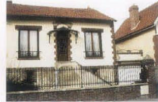
**L'enduit plâtre et chaux** est un revêtement régulateur d'humidité pour les façades anciennes.
