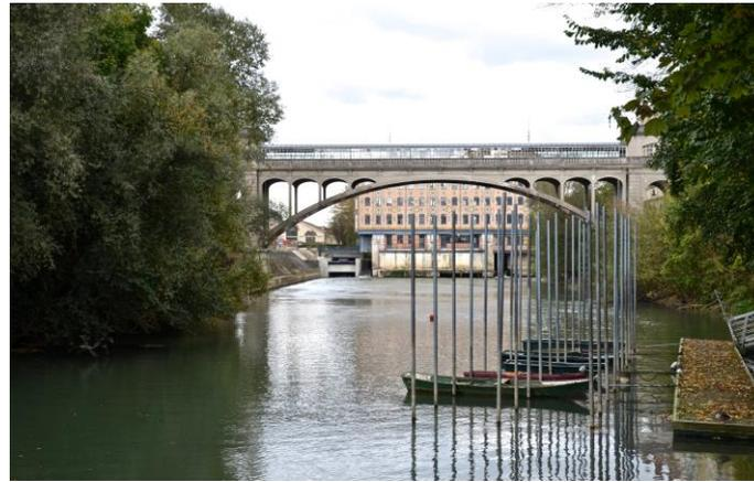
**Le Pont hardi** : passerelle de béton jetée sur la rivière en une seule arche de 44,50 m.
